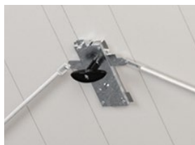
Cilinderslot vergrendelt de poort aan beide zijden
