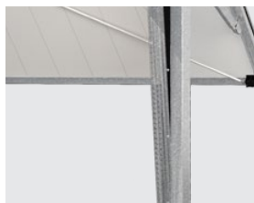
Trekverensysteem houdt het gewicht van het poortblad in balans.
