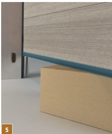
Onderloopbeveiliging bij automatische deuren
